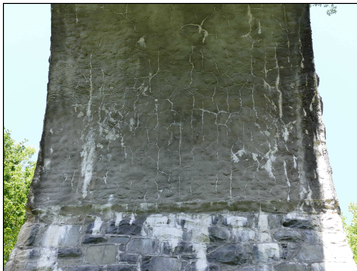
Foto č. 7 - Konstrukce K 09 – podhled, pata klenby, průsaky vody s výluhy pojiva a tvorba vápenných krust
