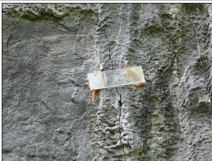
Foto č. 15 – Pilíř P 03 – vpravo z čela, svislá trhlina
