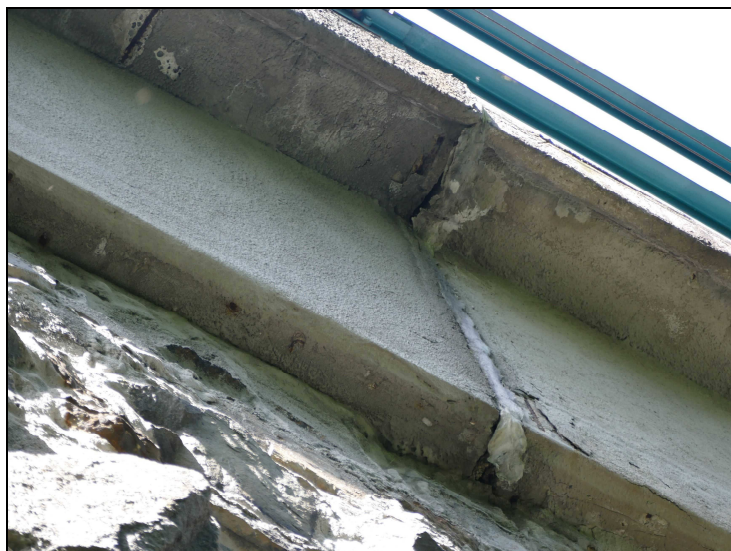
Foto č. 5 - Konstrukce K 06 – římsa vpravo, dilatace porušená
