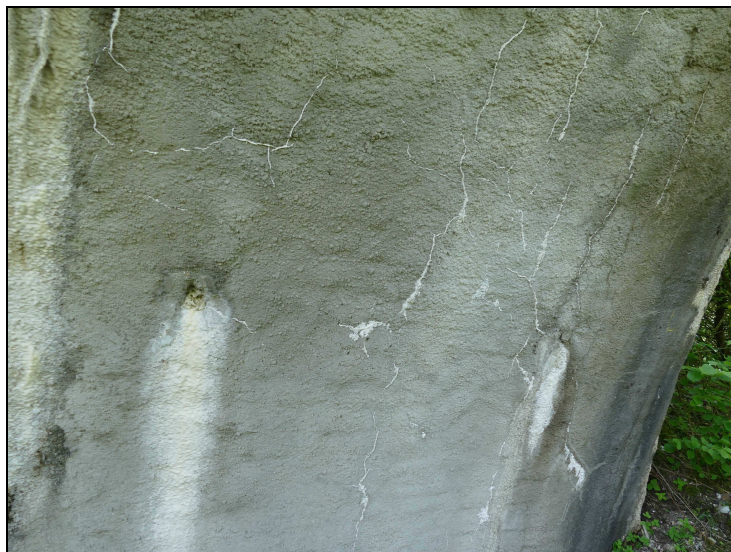
Foto č. 1 - Konstrukce K 01 – podhled, průsaky vody s výluhy pojiva a tvorba krust
