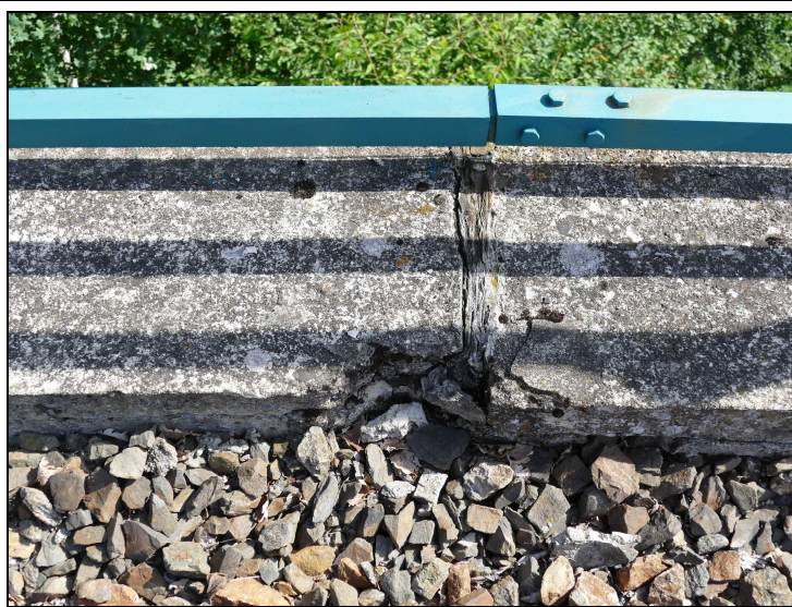
Foto č. 9 - Konstrukce K 10 – římsa vpravo, uražený roh
