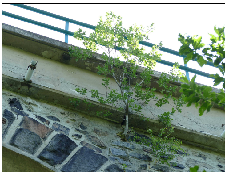
Foto č. 3 - Konstrukce K 02 – čelní zeď vlevo, nárůst stromku
