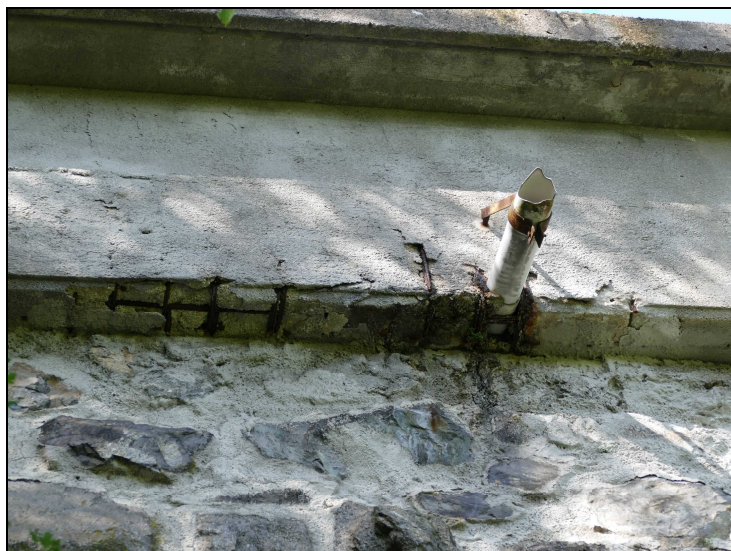
Foto č. 2 - Konstrukce K 01 – římsa vpravo, podhled, obnažená výztuž
