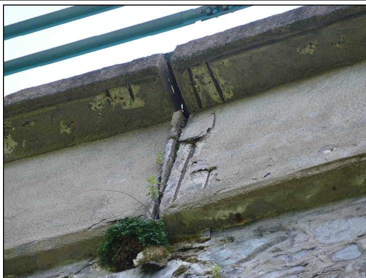
Foto č. 8 - Konstrukce K 09 – římsa vlevo, dilatace porušená
