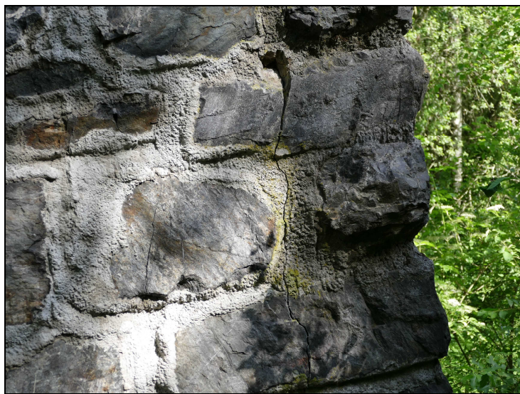
Foto č. 12 – Pilíř P 01 – v otvoru č. 1 vpravo, svislá trhlina
