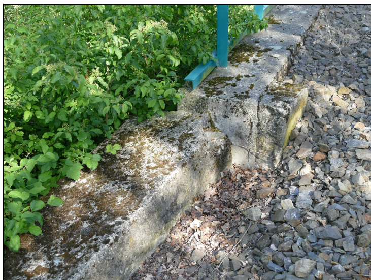
Foto č. 11 – Opěra O 01 – přechodová zídka vlevo, vysunutí a sesunutí
