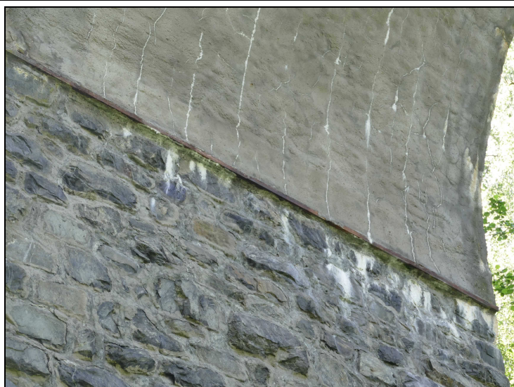
Foto č. 14 – Pilíř P 03 – v otvoru č. 4, průsaky vody s výluhy pojiva
