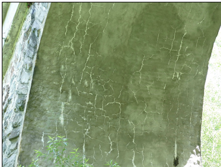
Foto č. 4 - Konstrukce K 05 – podhled, průsaky vody s výluhy pojiva
